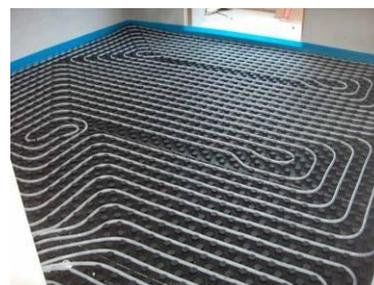
L' impianto è principalmente costituito da collettori di distribuzione con testine elettriche (il numero di circuiti aperti determina la modulazione dell' inverter delle pompe di circolazione dell' impianto di riscaldamento/raffrescamento) inseriti in cassette a muro, pannelli sagomati posati sottopavimento e una serie di circuiti chiusi con tubazioni in materiale composito all' interno delle quali scorre l' acqua calda/refrigerata prodotta dalle pompe di calore.
